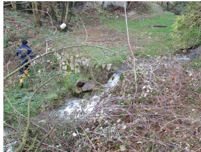
Foto 1-4 Rio Maggiore: presenza di ricca vegetazione arbustiva ed arborea crollata in alveo e nelle immediate vicinanze, ridotta sezione idraulica in alcuni tratti, manutenzione manufatti idraulici esistenti, taglio di vegetazione interferente con il deflusso idraulico, contenimento specie forestali alloctone
