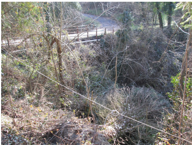
Foto 1-4 Rio Maggiore: presenza di ricca vegetazione arbustiva ed arborea crollata in alveo e nelle immediate vicinanze, ridotta sezione idraulica in alcuni tratti, manutenzione manufatti idraulici esistenti, taglio di vegetazione interferente con il deflusso idraulico, contenimento specie forestali alloctone
