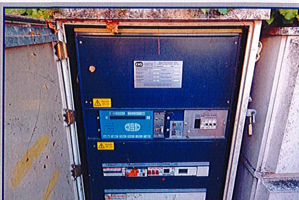
Quadro composto da regolatore di flusso da smantellare e rifare completamente (Q.6) – Via dei Martiri Colle Amano
