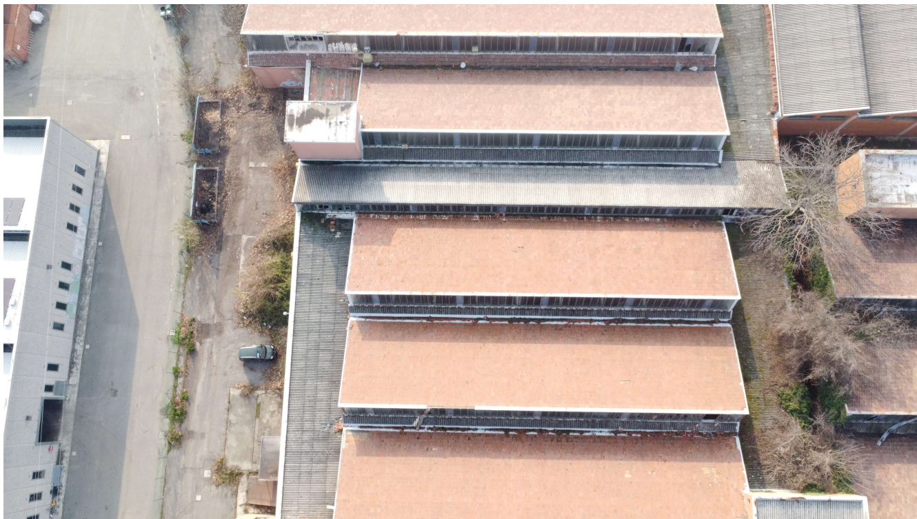
Fotografia 03. Vista delle coperture del corpo centrale di fabbrica e delle coperture di “raccordo” tra le strutture. Le ultime contengono amianto e rientrano quindi nel progetto di smaltimento
