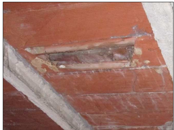
Foto n°8 - Particolare della conformazione costruttiva della Copertura A, classificabile come piano flessibile in quanto sprovvista di una soletta di completamento.
