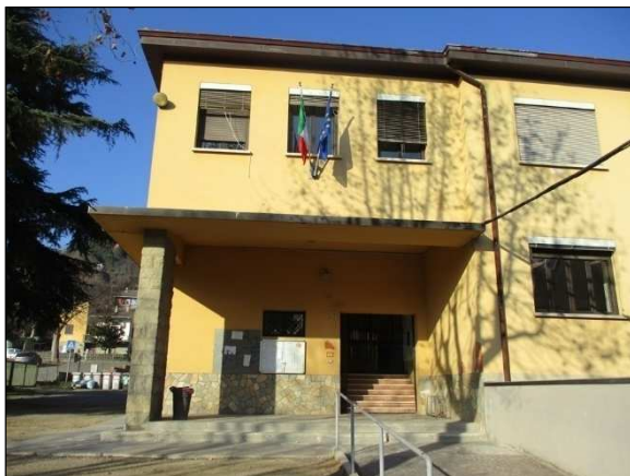
Foto n°6 - Maschi murari in falso e setto isolato collocati nella zona ove avviene l'ingresso.
