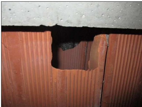
Foto n°12 - Particolare della conformazione costruttiva della Copertura B, classificabile come piano flessibile in quanto sprovvista di una soletta di completamento.
