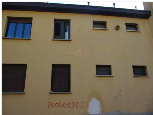
Foto n°2 - Accostamento tra US1 e US2 che avviene senza interposizione di giunto strutturale efficace sismicamente.
