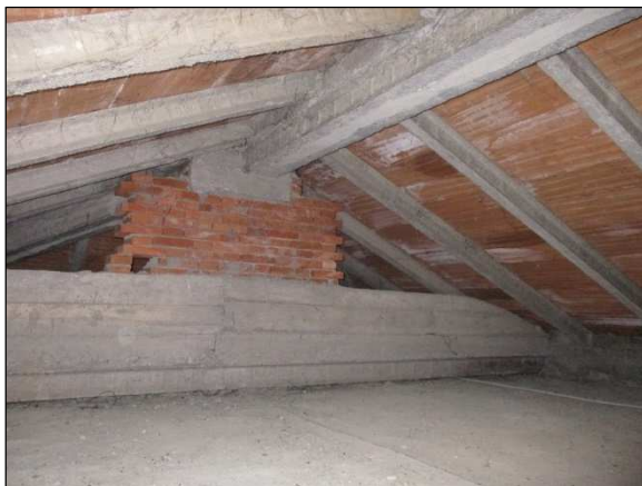
Foto n°9 - Irregolarità in elevazione costituita dalla trave.
