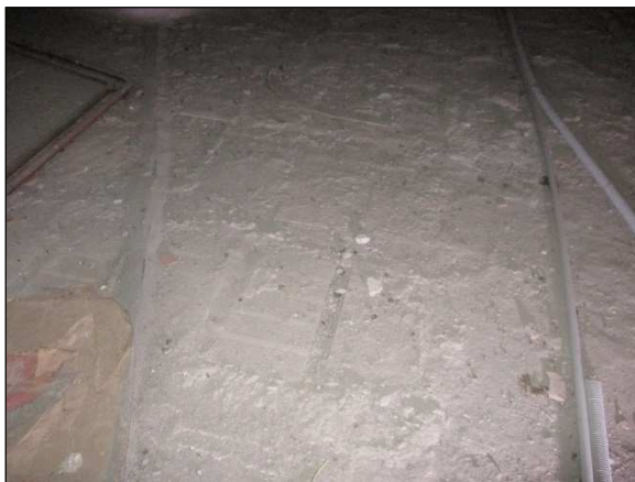
Foto n°7 - Vista dell'estradosso del Solaio D, classificabile come piano flessibile in quanto sprovvisto di una soletta di completamento.
