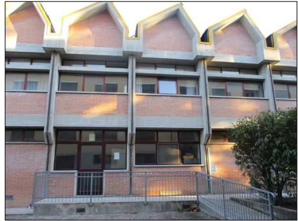
Foto n°15 - Vista di insieme del fronte Nord-Est in cui possibile analizzare la morfologia del fabbricato che definisce pilastri corti.
