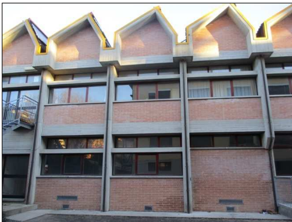
Foto n°16 - Vista di insieme del fronte Nord-Est in cui possibile analizzare la morfologia del fabbricato che definisce pilastri corti.
