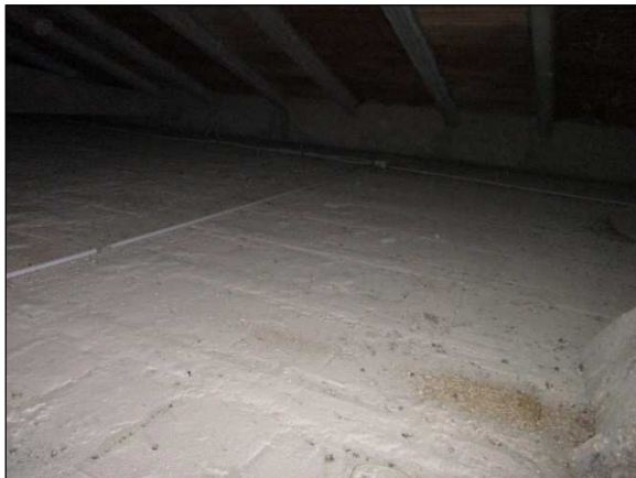
Foto n°4 - Vista dell'estradosso del Solaio B, classificabile come piano flessibile in quanto sprovvisto di una soletta di completamento.
