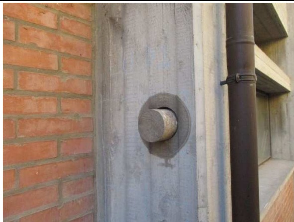
Prelievo campione calcestruzzo eseguito sul pilastro B05 al piano terra.
