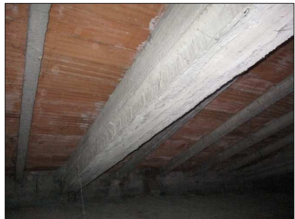
Foto n°10 - Irregolarità in elevazione costituita dalla trave.
