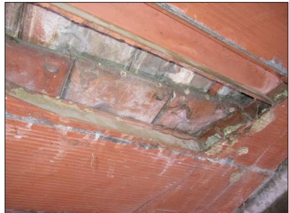
Foto n°5 - Particolare della conformazione costruttiva della Copertura A, classificabile come piano flessibile in quanto sprovvista di una soletta di completamento.
