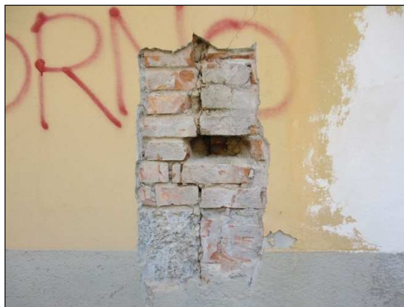
Foto n°3 - Scarificazione muraria condotta sul fronte Nord-Est in corrispondenza dell'accostamento dei due fabbricati, in cui individuabile l'accostamento delle scatole murarie.
